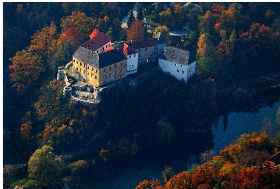
Zrinsko-Frankopanska utvrda Stari grad
